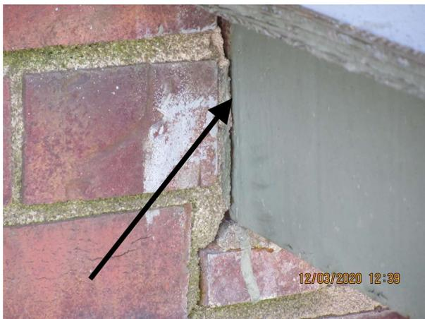
Jointes manquants dans la jonction de la structure en acier des balcons.
