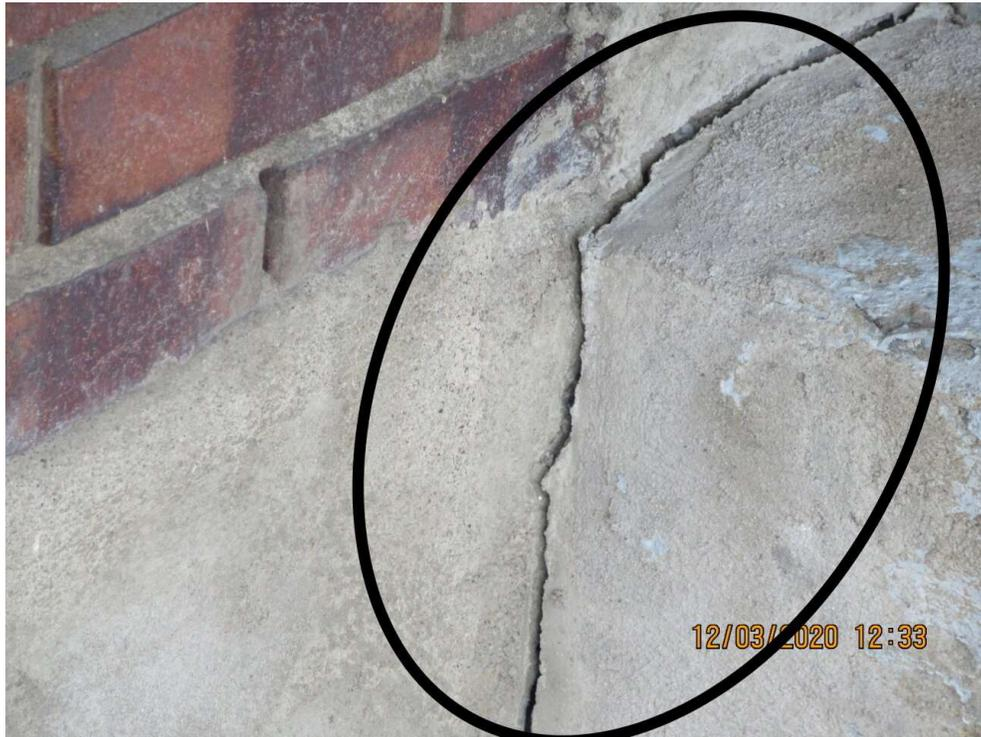
Mouvement différentiel entre les murs de soutènement de béton et le mur de fondation.
