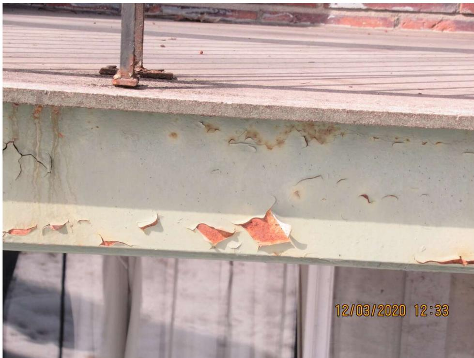
Structure de balcon rouillée et écaillée
