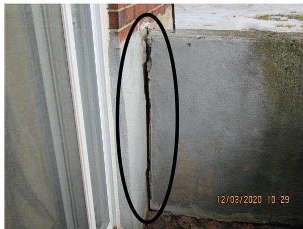
Mouvement différentiel du mur de soutènement
