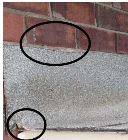
Ouverture sur la membrane et solins de jonction de toit manquant.
