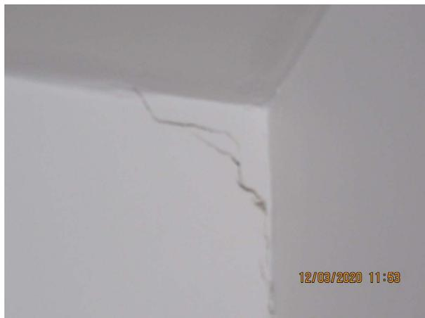
Jonction mur et plafond lézardement occasionné par un mouvement structurale au dernier étage
