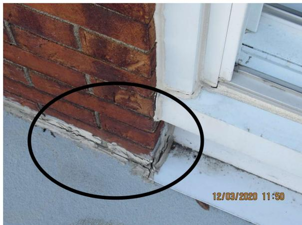
Jonction à calfeutrer entre la plateforme du balcon et le mur extérieur en aluminium.
