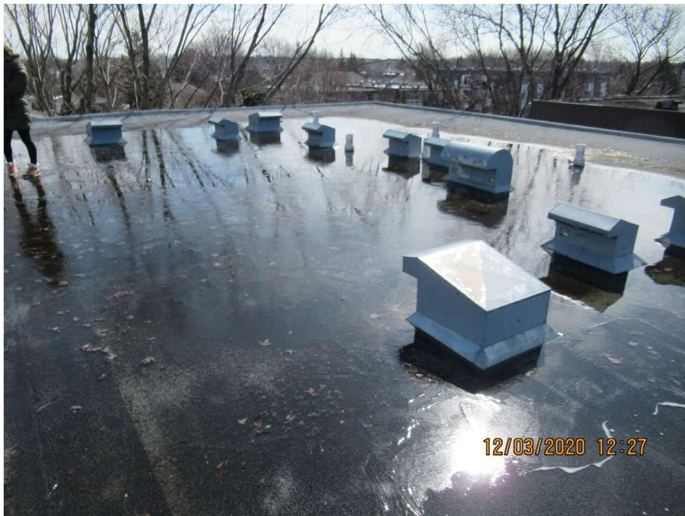
Accumulation d'eau dû à la déficience de drainage de la toiture.
