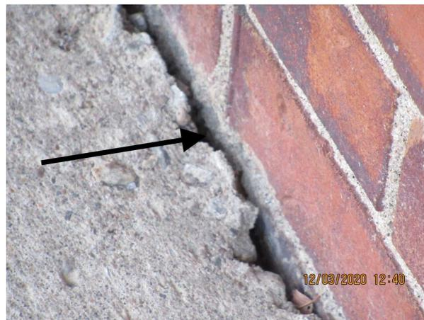
Scellant manquant dans la jonction de mur et dalle de béton.
