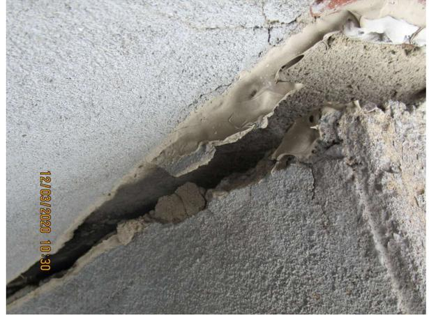
Mouvement différentiel du mur de soutènement en béton
