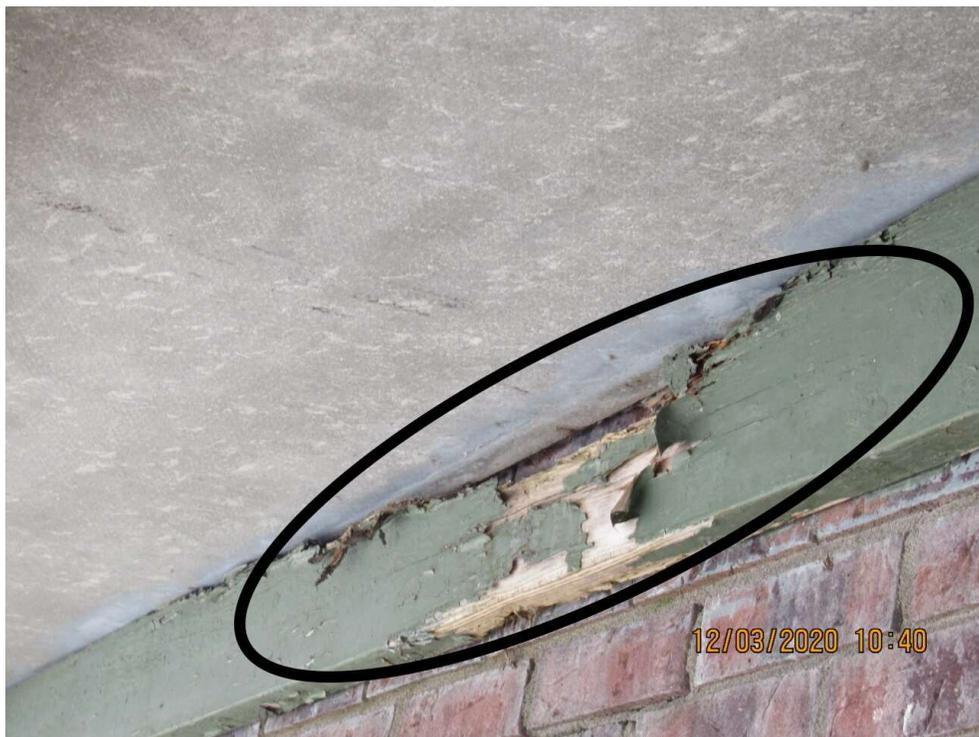
Structure du balcon avant au rez-de-chaussée détériorée
