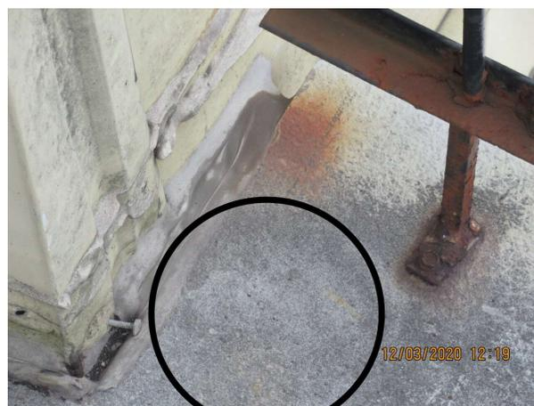
Surface du balcon inégale et déformée et cernes d'eau visibles.
