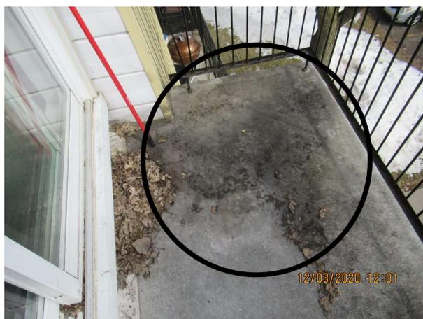
Surface du balcon inégale et déformée et cernes d'eau visibles.
